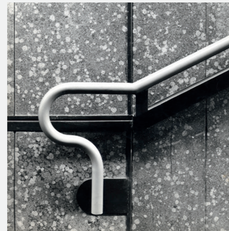
Corrimano della Metropolitana Milanese. Progetto di F. Albini e F. Helg, 1964/ Handrail of the Milan Underground. Project by F. Albini, F. Helg, 1964
